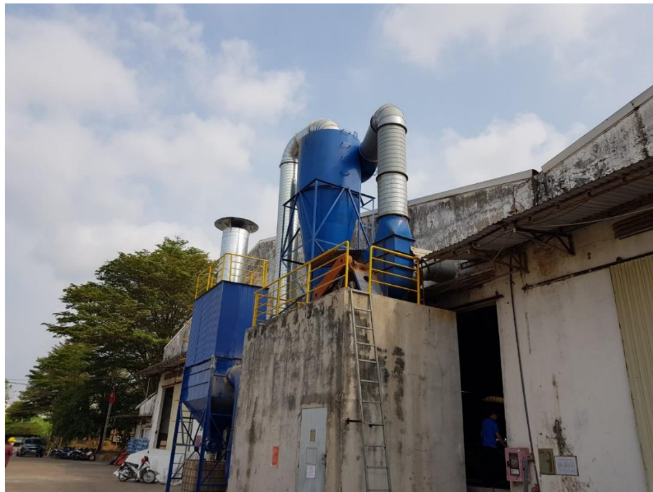
Hình 3-6 Hệ thống thu gom và xử lý bụi gỗ bằng cyclone kết hợp lọc bụi cartridge công suất 24.000 m 3 /giờ
